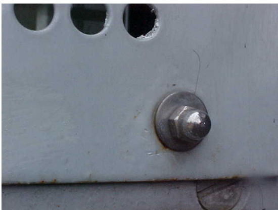
Ogenscheinlijk intacte ondergrond en verfsysteem.
