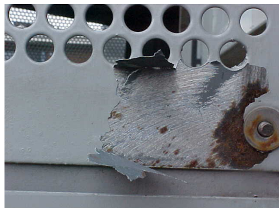
Corrosie onder het verfsysteem
