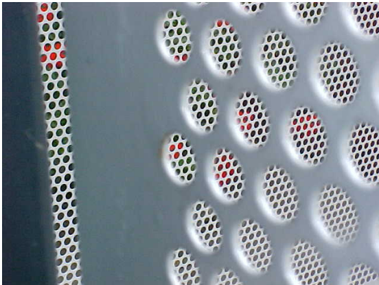
Een beginnende roestplek zichtbaar aan de binnenzijde van de beplating.
