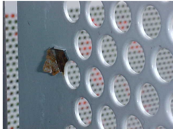
Onder het verfsysteem is de corrosie aanzienlijk gevorderd.
