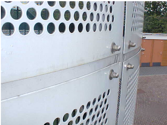
Lichte roestplekken zichtbaar aan de onderzijde (rand) van het paneel.
